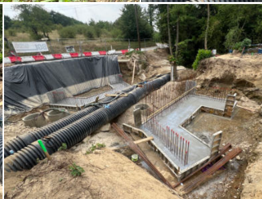
Semelles des piliers en béton
