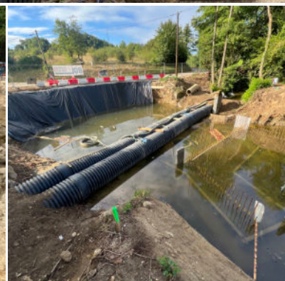
Le chantier est très difficile
