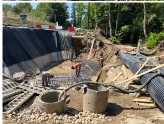
Préparation et ferrailage de la semelle
