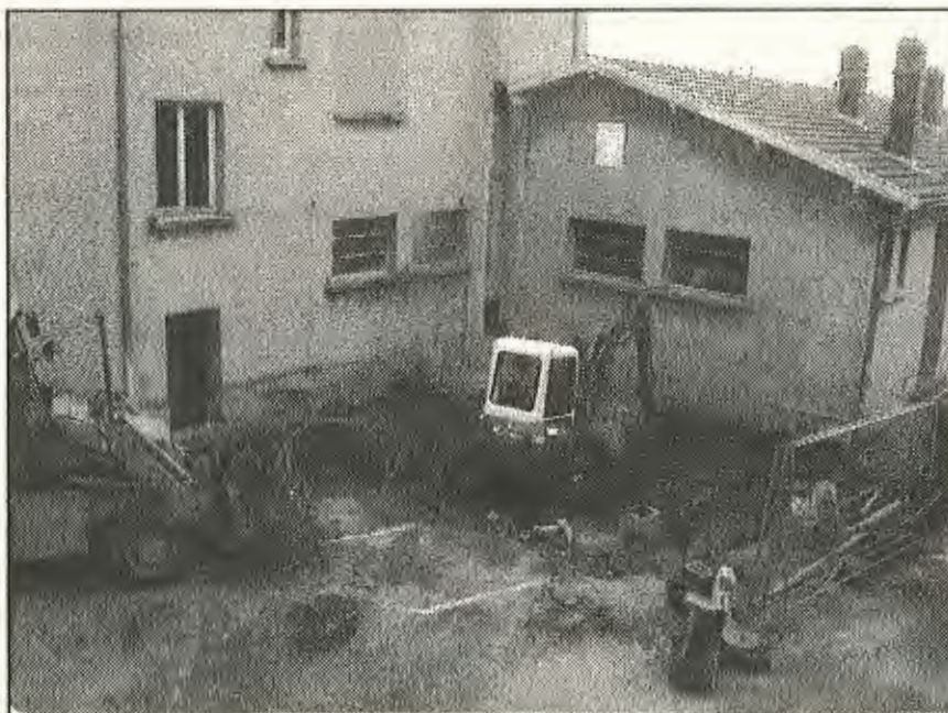
Les travaux de la chaufferie des écoles ont commencé
