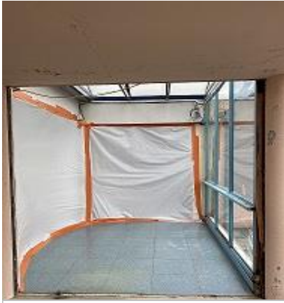
Démontage hall entrée
