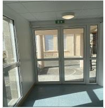
Intérieur hall terminé
