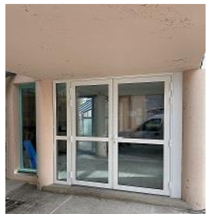
Montage baie vitrée
