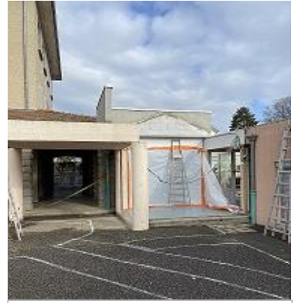
Démontage hall entrée
