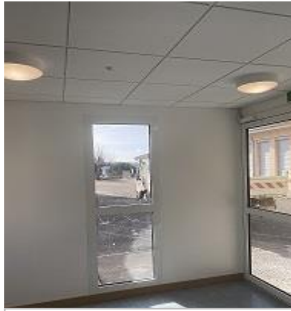
Intérieur hall terminé
