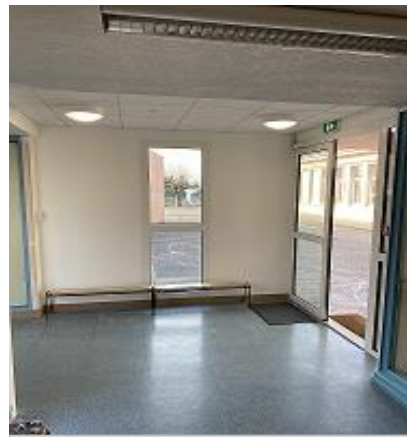
Intérieur hall terminé
