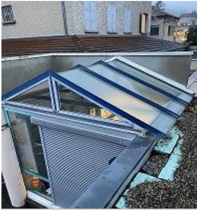
Toiture hall entrée
