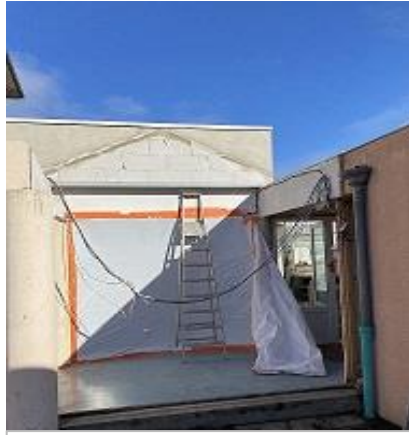
Démontage hall entrée
