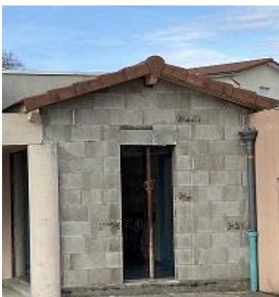
Montage mur et toiture
