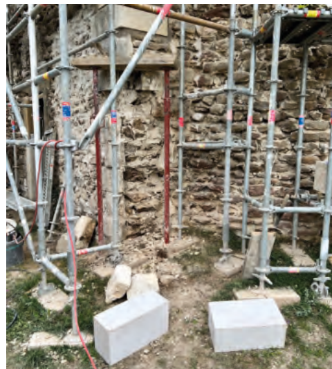
Pose des échafaudages à l'intérieur et à l'extérieur
