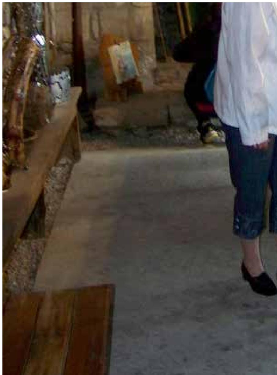
Vue de la dalle en béton avec périphérie en gravillons avant recouvrement par des tomettes
