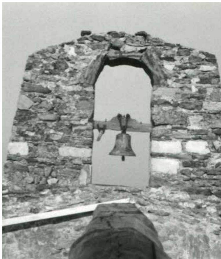
Vue du mur-clocher sans sa couverture en tuiles
