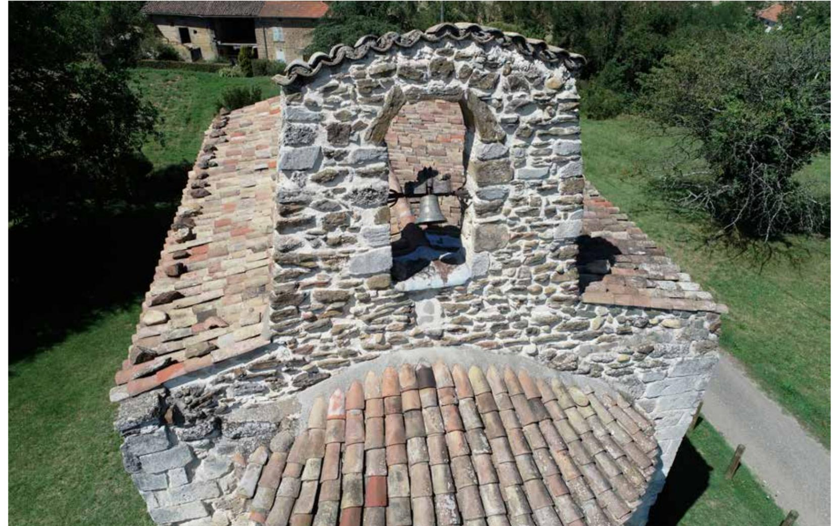
Façade Est du mur clocher, joints récents à la chaux, teinte claire, mise en oeuvre légèrement trop creusées
