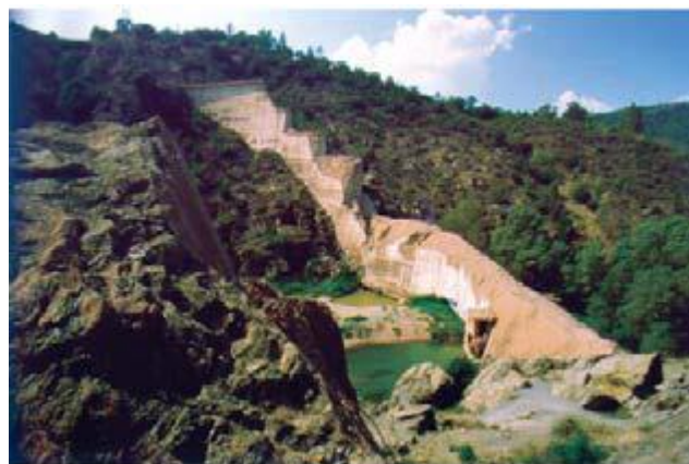
Restes du barrage
