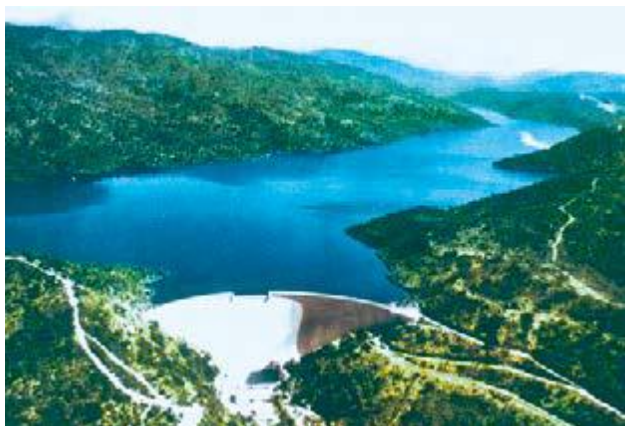
Barrage avant la catastrophe
